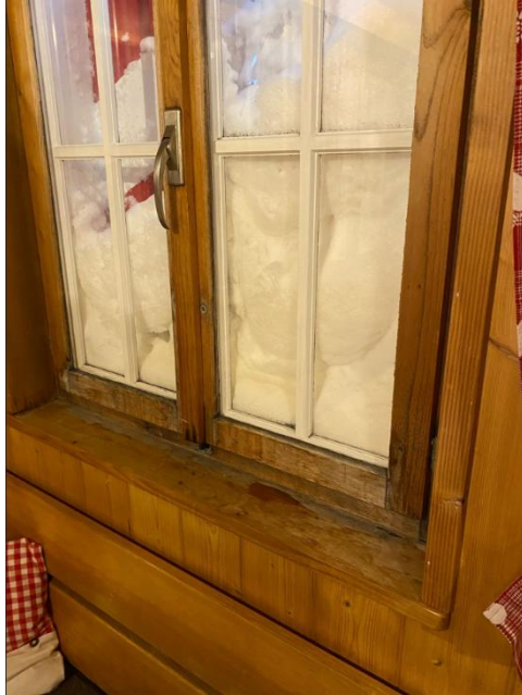
Bilder: Fenster mit Schwitzwasser und Fenster, beide Bilder im Speiseraum aufgenommen
