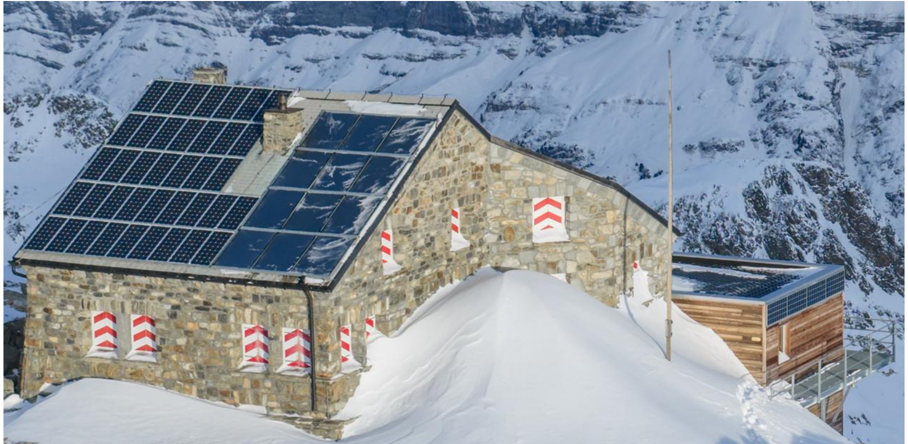
Ansicht: Südseite, PV und therm. Kollektor
